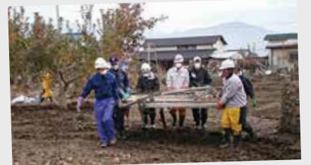
流れてきたソーラーパネルの撤去作業
